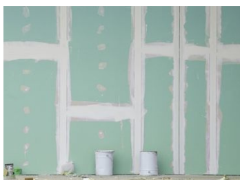
Ouverture de chantier et achèvement
