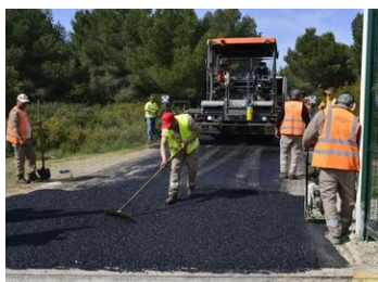
Travaux sur la voie publique
