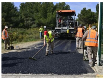
Travaux sur la voie publique
